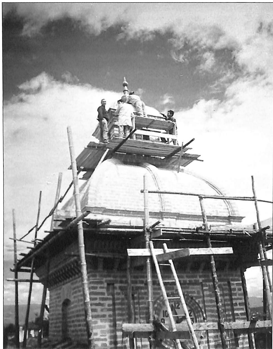
Foto 11: Reparación bóveda y cupulín. Archivo Ing. Carlos Jaramillo V. 1994
